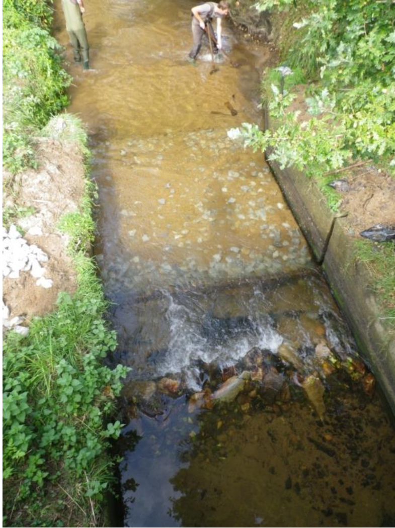
Figure 2: vue vers l'aval de l'enrochement mis en place dans la partie aval du futur déversoir artificiel (remarque : les roches massives visibles dans le bas de la photo ont été positionnées ainsi lors de la mise en place de l'enrochement afin de limiter l'afflux de sable puis retirées à la fin de l'installation du seuil) © EPAB 2013
