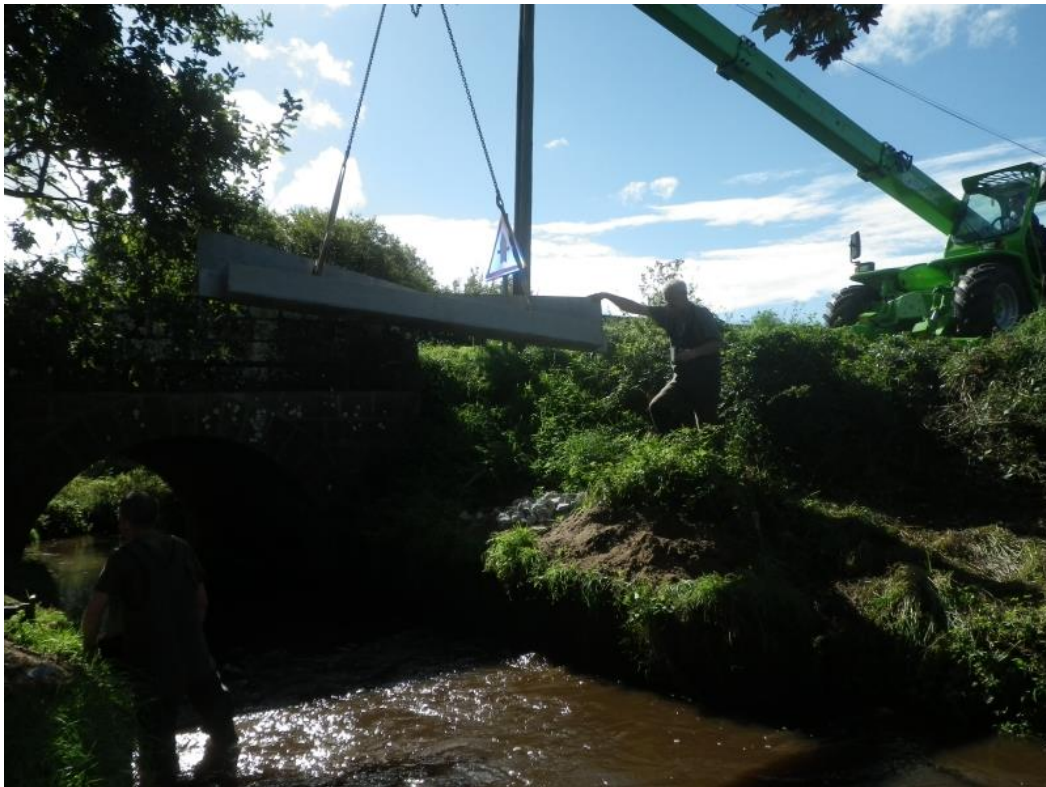
Figure 3: déversoir en cours de pose ó EPAB 2013
