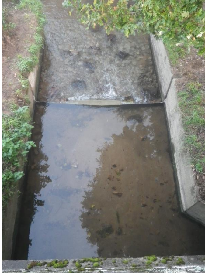
Figure 4: vue du déversoir posé (vers l'aval) ó EPAB 2013
