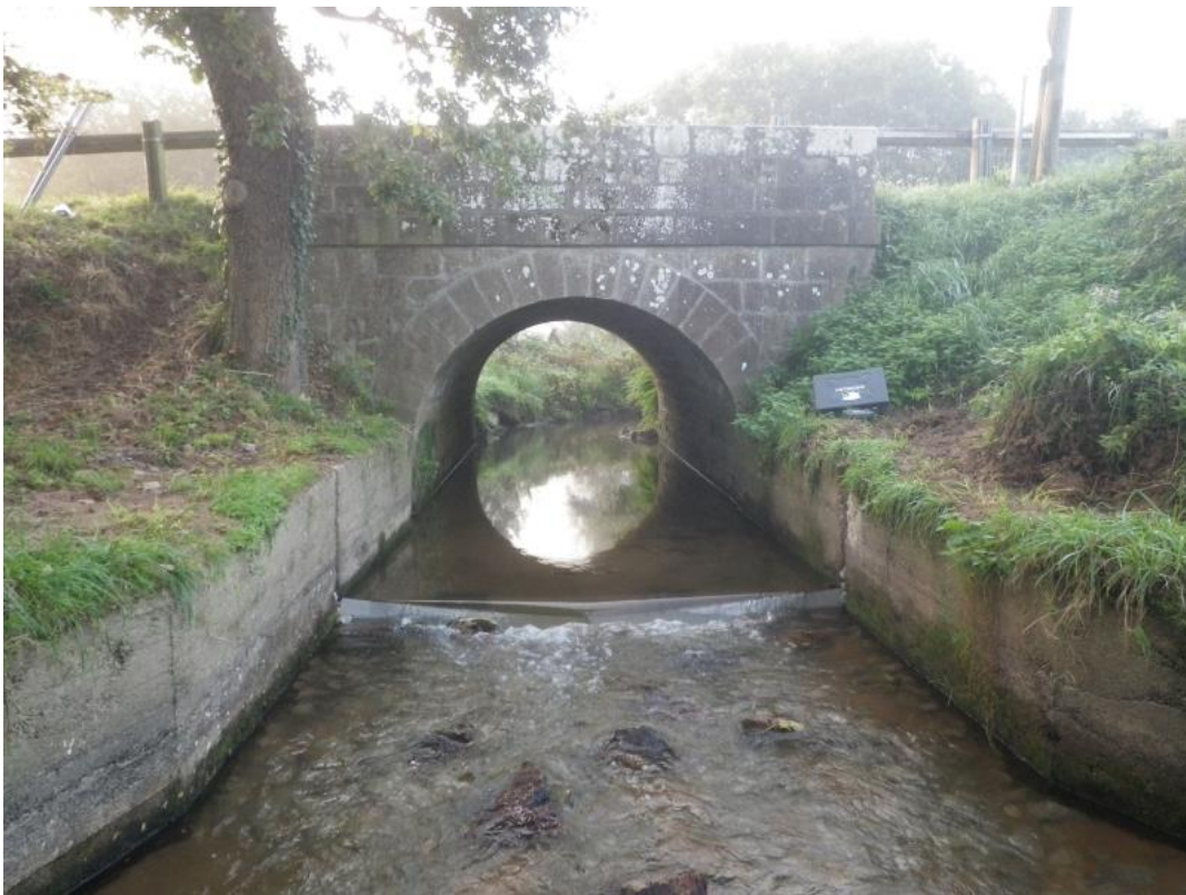
Figure 5 : vue du déversoir posé (vers l'amont) ó EPAB 2013
