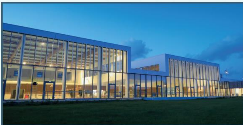
Façade du Stade aquatique.
