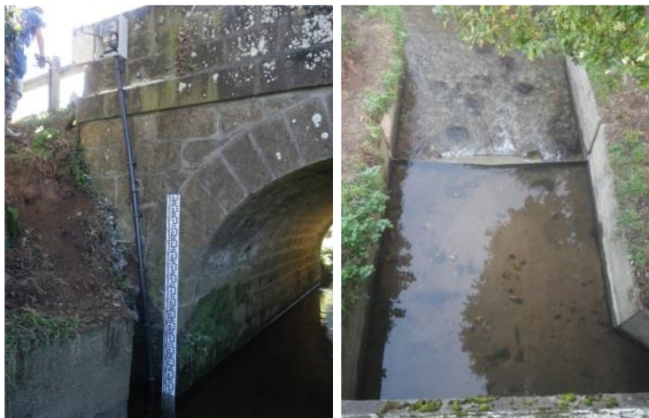
Figure 4 : station hydrométrique du Ris avec contrôle et seuil artificiels (déversoir en V) - EPAB, 2015
