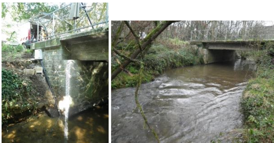
Figure 5 : Station hydrométrique du Kerharo avec contrôle et seuil naturels – EPAB, 2015
