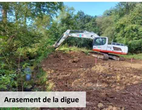
Nivellement du terrain
