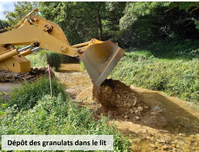
Dépôt des granulats dans le lit
