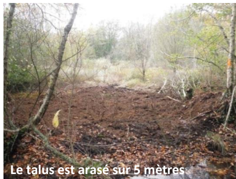
L'ouverture du talus permet l'entrée d'eau dans la zone humide
