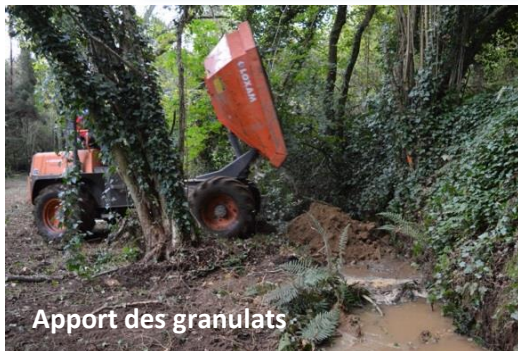
Mise en place des granulats
