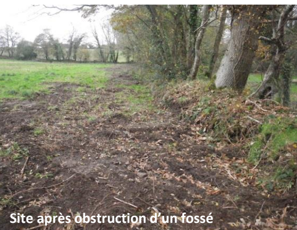
Site avant travaux
