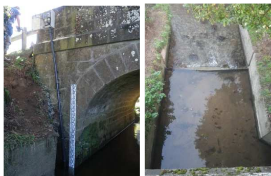
Figure 4 : Photographies de la station hydrométrique du Ris et du déversoir en V
