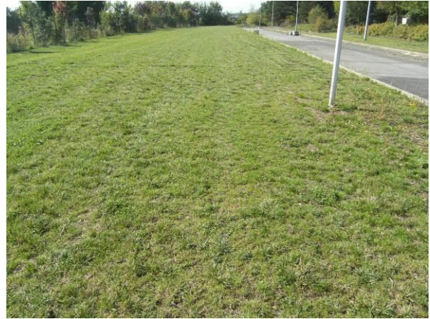
Photo 13 : Enherbement avec un apport de moins de 3 cm d'un mélange sable-terre-terreau (Angers, 49)
