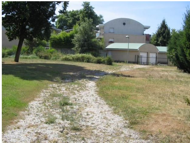
Photo 5 : Enherbement d'une allée stabilisée (Bordeaux, 33)
