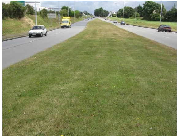
Figure 19 : Terre-plein central enherbé par semis hydraulique (Brest, 29)
