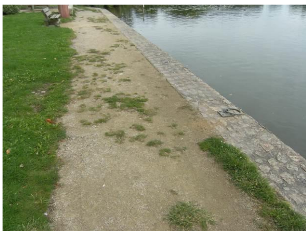
Photo 7 : Enherbement n'ayant pas pris. Cela est sûrement lié à la fréquentation ou à la date de semis (La Chapelle-sur-Erdre, 44)
