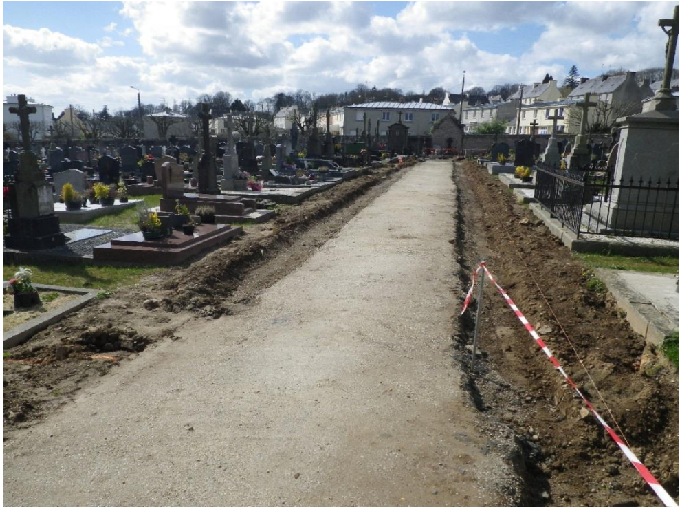
Allée en cours de réaménagement
